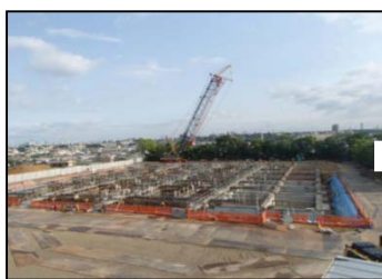
6月13日時点での工事状況全景
